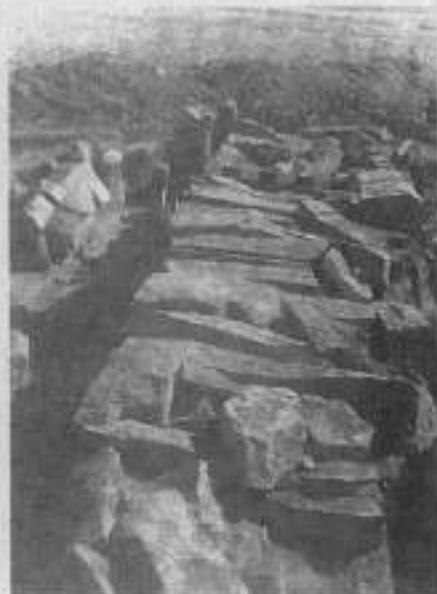
Рис. 62. Сангру I. Техника горизонтальной кладки
